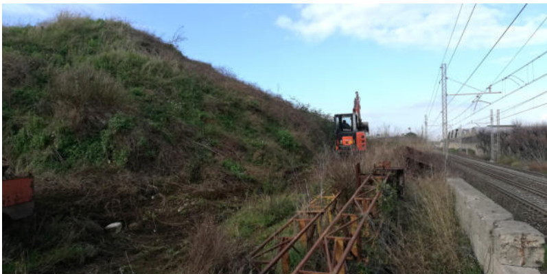
Vista strada interna est-ovest con ferrovia lato nord
